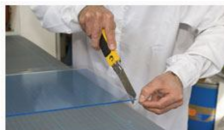
Излишки плёнки обрезаются острым ножом
